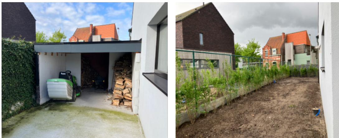
Foto's: verhardingen en een aanbouw aan de woning in de bouwvrije strook (foto links) werden verwijderd na aanmaning (foto rechts), dankzij onze tussenkomst.
