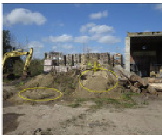
Foto links en beide foto's onder, uit ons jaarverslag van 2018: op terrein liggen verschillende hopen grond gemengd met asbest. Foto rechtsboven van 2023: de hopen grond zijn verwijderd. De site krijgt nu een nieuwe invulling.
